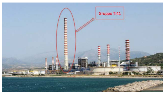
Figura 1. La centrale termoelettrica "Ettore Majorana" di Termini Imerese: ha abbandonato l'olio combustibile in favore di gruppi di generazione più piccoli alimentati a gas naturale con cui è più semplice seguire i picchi di domanda quando la disponibilità della generazione da rinnovabili si abbassa (Fotografia di Hervard Dunkel, Flickr).
