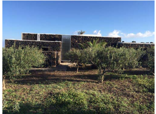
Figura 4. Collettore solare ad aria, installato sulla facciata di un edificio a Pantelleria: fino a 250 mc/ora di aria calda, ricca di ossigeno e asciutta che immessa ogni giorno nell'abitazione durante le ore diurne la riscalda e sanifica gratuitamente.
