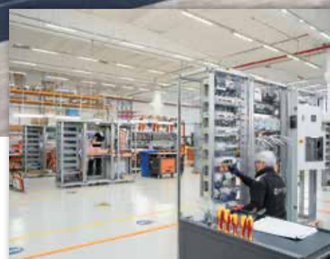
Produzione Quadri Elettrici
