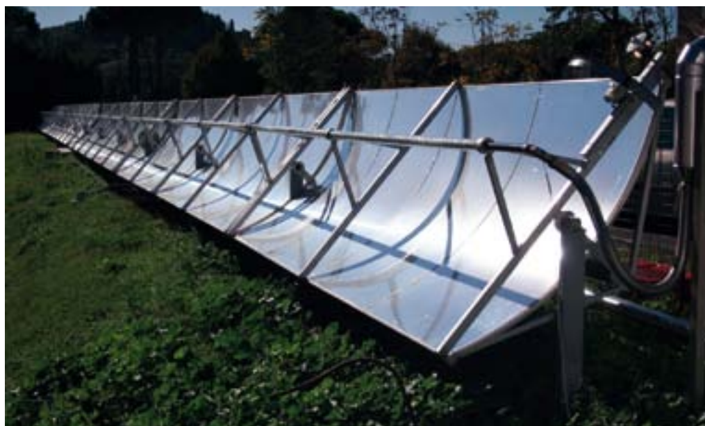
Impianto solare a concentrazione, Comune di Firenze
