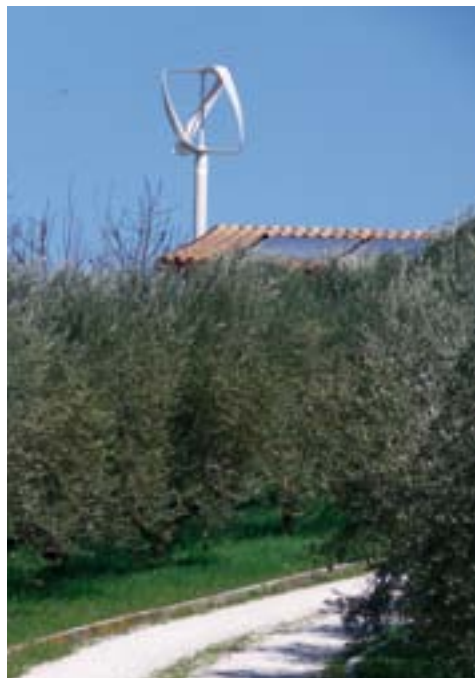
impianto mini eolico nel Comune di Monsano (AN)
