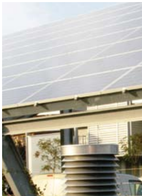
Impianto solare fotovoltaico su pensilina Comune di Conselice (RA)
