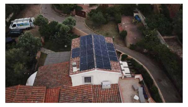
INTERVENTO REALIZZATO DA ENERGIE RINNOVABILI PETRETTO, SI TRATTA **DELL'INSTALLAZIONE** DI UN IMPIANTO FOTOVOLTAICO DA 6 KWP CON 15 MODULI FOTOVOLTAICI OCELLS DELLA POTENZA DI 400 W. L'IMPIANTO SFRUTTA UN INVERTER AZZURRO 1PH HYBRID 6000 ZSS E NON È DOTATO DI SISTEMA DI ACCUMULO. IL LAVORO È STATO FATTO SFRUTTANDO LA DE-TRAZIONE FISCALE AL
