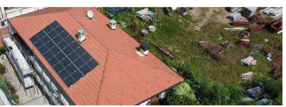
INTERVENTO IN **SUPERBONUS** REALIZZATO DA CARBOFF ITALIA. L'EDIFICIO. SITUATO A LONATE POZZOLO IN PROVINCIA DI VARESE. È STATO DOTATO DI IMPIANTO FOTOVOLTAICO DA 6.64 KWP COMPOSTO DA 16 PANNELLI LG DA 415 W CON INVERTER SOLAREDGE **E OTTIMIZZATORI** E BATTERIA TESLA POWERWALL DA 13,5 KWH
