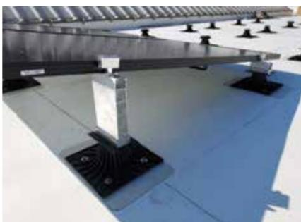
delle prestazioni del sistema impermeabilizzante. Infine Soprasolar esiste anche nella versione FIX EVO Tilt che, grazie ai suoi rialzi, permette un'inclinazione di 10° dei pannelli fotovoltaici, per ottenere la migliore esposizione al sole e migliorare la resa energetica. Soprasolar prevede inoltre un servizio di consulenza tecnica personalizzata durante tutte le fasi del progetto.
