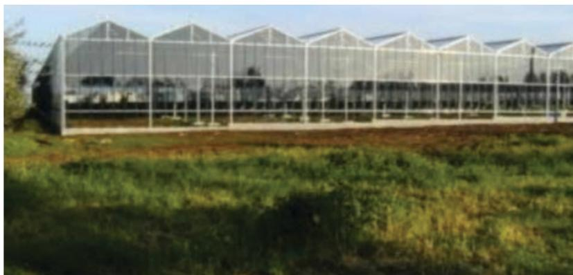
NEL 2009 A LATINA BELECTRIC ITALIA HA REALIZZATO UNA SERRA FOTOVOLTAICA CON POTENZA PARI A 1,5 MWP E UNA PRODUZIONE ANNUA DI CIRCA 2,2 GWH. L'IMPIANTO, SITUATO A 4,5 METRI DI ALTEZZA, FUNGE DA COPERTURA A VARIE COLTIVAZIONI E CONSISTE IN 20.110 PANNELLI FIRST SOLAR THIN-FILM TECHNOLOGY. L'IMPIANTO, CHE OCCUPA UNA SUPERFICIE TOTALE DI 2,5 ETTARI, CONSENTE UN RISPARMIO DI ANIDRIDE CARBONICA PARI A 1150 TONNELLATE ALL'ANNO.
