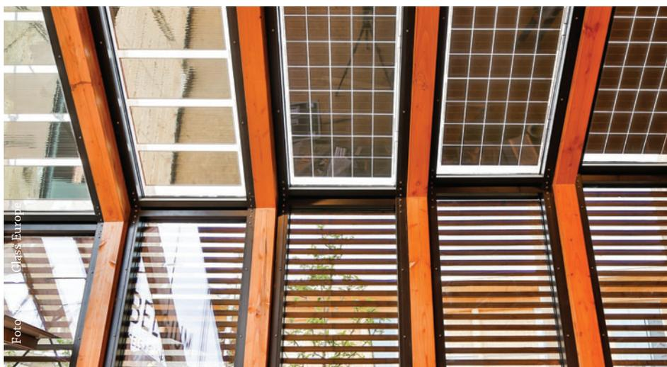
LA COPERTURA SOLARE DELLA FATTORIA DEL PADIGLIONE DEL BELGIO È REALIZZATA CON VETRI AGC GLASS EUROPE DEI QUALI ALCUNI INCLUDONO UNA PELLICOLA SOLARE ORGANICA (A SINISTRA) E ALTRI CELLE FOTOVOLTAICHE (A DESTRA)
