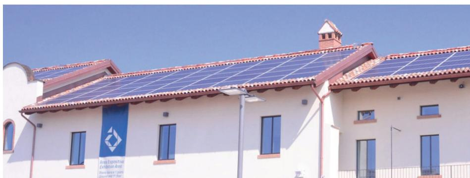
SUL TETTO DELLA CASCINA TRIULZA, CHE OSPITA IL PADIGLIONE DELLA SOCIETÀ CIVILE, È STATO REALIZZATO UN IMPIANTO FOTOVOLTAICO DA 94 KW
