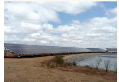
È in fase di costruzione a Benslimane, nel nord-ovest del Marocco, l'impianto da 297 kWp costituito da circa 1.144 moduli policristallini Conergy PowerPlus e undici inverter SMA, che produrrà energia destinata ad alimentare il sistema di pompaggio dell'acqua nelle vasche della locale stazione di trattamento.
