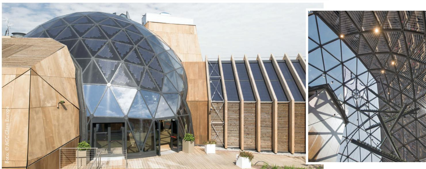
IL PADIGLIONE DEL BELGIO È DOTATO DI UN IMPIANTO FOTOVOLTAICO ESTESO SU UNA SUPERFICIE DI 315 METRI QUADRI CHE FORNISCE 130 KWH DI ENERGIA ELETTRICA PULITA AL GIORNO
