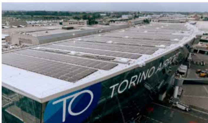
È entrato in funzione a Torino Airport un impianto fotovoltaico da 1,4 MWp. L'impianto è costituito da 3.651 moduli SunPower che coprono una superficie pari a 6.454 metri quadri. L'installazione, realizzata dalla società ATI, prevede anche l'uso di 14 inverter e ottimizzatori SolarEdge. All'inaugurazione, avvenuta l'11 luglio, erano presenti anche il presidente della Regione Piemonte Alberto Cirio e l'assessora alle Attività Produttive della Città di Torino Gianna Pentenero. Il nuovo
