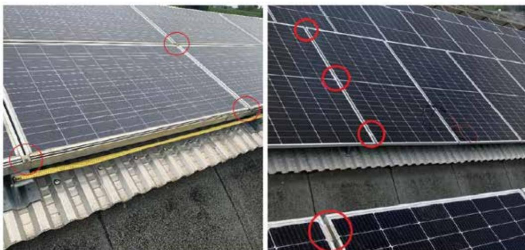
PER L'INSTALLAZIONE DEI NUOVI MODULI SONO STATI UTILIZZATI MORSETTI IN ALLUMINIO AD "Ω ROVESCIATO", PER I FISSAGGI INTERMEDI, ED A "Z". PER I FISSAGGI ALLE ESTREMITÀ DELLA STRUTTURA, RISPETTO A QUELLA ORIGINARIA, DOVE I MODULI RISULTAVANO DISPOSTI ORIZZONTALMENTE IN DUE FILE ED INCASSATI ALL'INTERNO DEI PROFILI LONGITUDINALI IN ALLUMINIO, NELLA NUOVA CONFIGURAZIONE I MODULI RISULTANO APPOGGIATI SOPRA I SUDETTI PROFILI
