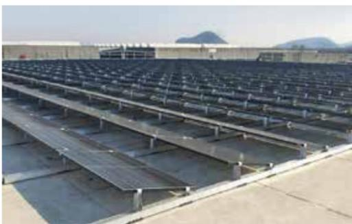
Contact Italia lancia sul mercato due nuovi prodotti. Si tratta dei sistemi di montaggio Feetnet e Tilt. Il primo è stato sviluppato per impianti fotovoltaici su tetti piani. Il secondo, invece, è stato ideato per impianti su lamiera grecate piane e curve.
