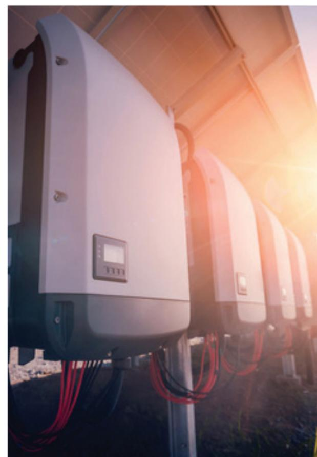
INIZIALMENTE IL COMPITO DI UN INVERTER ERA LA SEMPLICE CONVERSIONE DA CORRENTE CONTINUA AD ALTERNATA. CON IL PASSARE DEL TEMPO, QUESTI DISPOSITIVI HANNO IMPARATO A GESTIRE MOLTE PIÙ FUNZIONI, TRA CUI MONITORAGGIO, ACCUMULO, INTEGRAZIONE CON LA RETE E SICUREZZA
