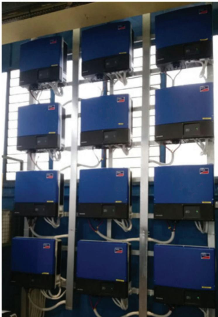
L'INSTALLATORE HA ALLACCIATO L'IMPIANTO A 12 INVERTER SMA SUNNY TRIPOWER, CHE GARANTISCONO ELEVATA EFFICIENZA, VERSATILITÀ E RENDONO POSSIBILE UN CORRETTO DIMENSIONAMENTO DELL'IMPIANTO GRAZIE AL SOFTWARE ABBINATO
