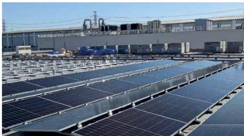
UN DETTAGLIO DEI SISTEMI DI MONTAGGIO DOME SL PER MODULI DI GRANDI DIMENSIONI. L'AGGANCIAMENTO AVVIENE SUL LATO LUNGO DEL PANNELLO PER GARANTIRE MAGGIORE STABILITÀ.
