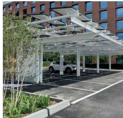
L'INSTALLAZIONE OCCUPA UNA SUPERFICIE DI 1.400 METRI QUADRATI PER UNA POTENZA COMPLESSIVA PARI A 250 KWP. IN FUTURO SI PREVEDE LA REALIZZAZIONE DI PENSILINE FOTOVOLTAICHE PERIMETRALI
