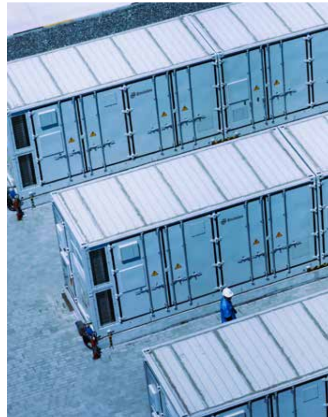
IL SISTEMA DI STORAGE BLACKHILLOCK CONNESSO ALLA RETE DI TRASMISSIONE SCOZZESE, DOTATO DI TECNOLOGIA GRID-FORMING FORNITA DA SMA. I BENEFICI PREVISTI INCLUDONO RISPARMI PER OLTRE 170 MILIONI DI STERLINE PER I CONSUMATORI
