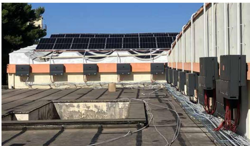
L'UTILIZZO DI MODULI BIFACCIALI HA RICHIESTO IL COLLEGAMENTO CON INVERTER CHE FOSSERO IN GRADO DI GESTIRE CORRENTI MOLTO ALTE: UNA DELLE PARTICOLARITÀ DEGLI INVERTER KOSTAL È QUELLA DI SUPPORTARE CORRENTI FINO A 18 A E QUINDI RISULTARE ADATTI A QUESTA TIPOLOGIA DI IMPIANTI.
