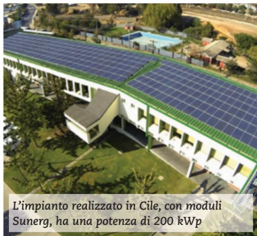
L'impianto realizzato in Cile, con moduli Sunerg, ha una potenza di 200 kWp
