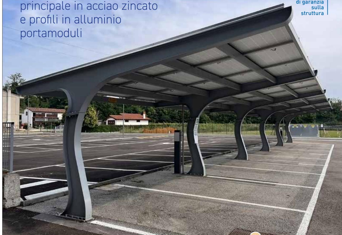
Il sistema Pensilina è composta da una **sottostruttura portante in acciaio zincato a caldo** e un'orditura di **profili in alluminio** per l'installazione di moduli fotovoltaici.
