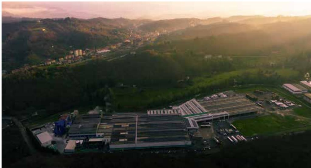
SUL TETTO DELLO STABILIMENTO DI VETTERIA ETRUSCA AD ALTARE, IN PROVINCIA DI SAVONA, È STATO INSTALLATO UN IMPIANTO FOTOVOLTAICO DELLA POTENZA DI 2.4 MWP. IL 100% DELL'ENERGIA GENERATA VERRÀ AUTOCONSUMATA DIRETTAMENTE DALLO STABILIMENTO. GRAZIE A QUESTO PROGETTO, LA PERCENTUALE DI ENERGIA ELETTRICA PROVENIENTE DA FONTI RINNOVABILI AUTOCONSUMATA DALLO STABILIMENTO PASSERÀ DAL 38% AL 43%
