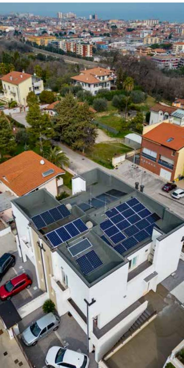
INTERVENTO REALIZZATO DA GREENPRIME SU ABITAZIONE BIFAMILIARE SITUATA A MONTESILVANO. IN PROVINCIA DI PESCARA. È STATO INSTALLATO CON DETRAZIONE FISCALE AL 50% UN IMPIANTO FOTOVOLTAICO DA 3 KWP COMPOSTO DA 10 MODULI PEIMAR DA 350 W, INVERTER ABB, SENZA ACCUMULATORI. L'INTERVENTO HA PREVISTO ANCHE L'INSTALLAZIONE DI UN IMPIANTO SOLARE TERMICO.
