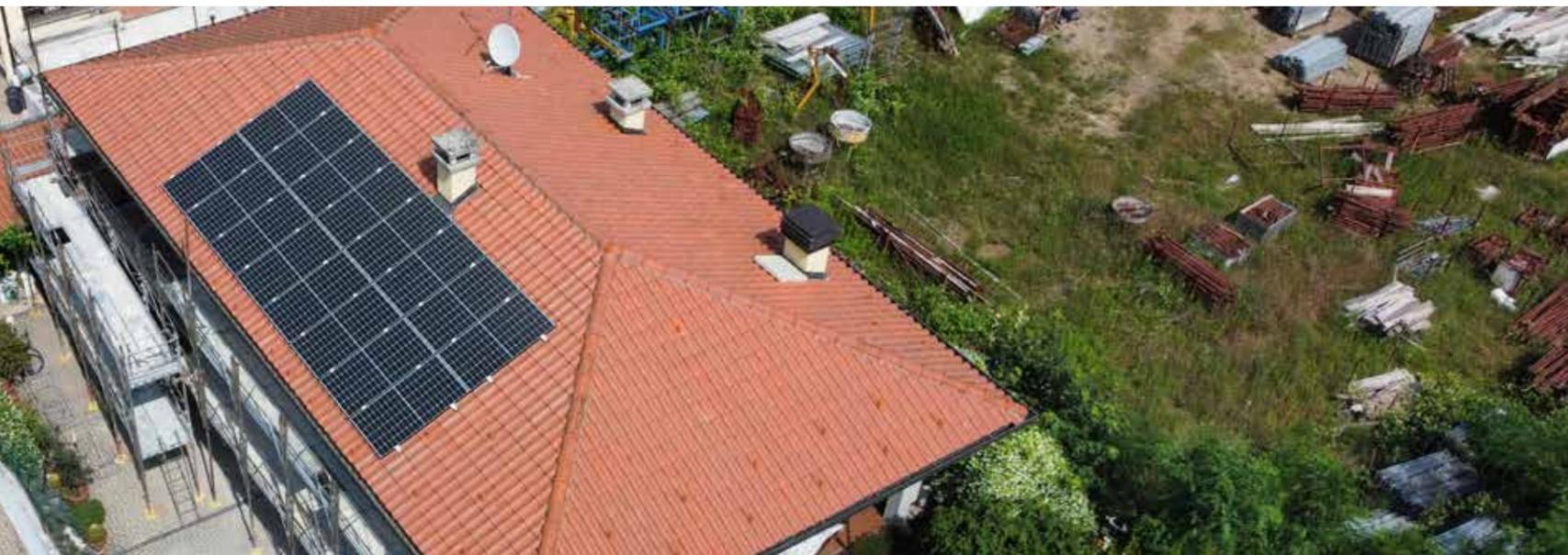
INTERVENTO IN SUPERBONUS REALIZZATO DA CARBOFF ITALIA. L'EDIFICIO, SITUATO A LONATE POZZOLO IN PROVINCIA DI VARESE, È STATO DOTATO DI IMPIANTO FOTOVOLTAICO DA 6,64 KWP COMPOSTO DA 16 PANNELLI LG DA 415 W CON INVERTER SOLAREEDGE E OTTIMIZZATORI E BATTERIA TESLA POWERWALL DA 13,5 KWH
