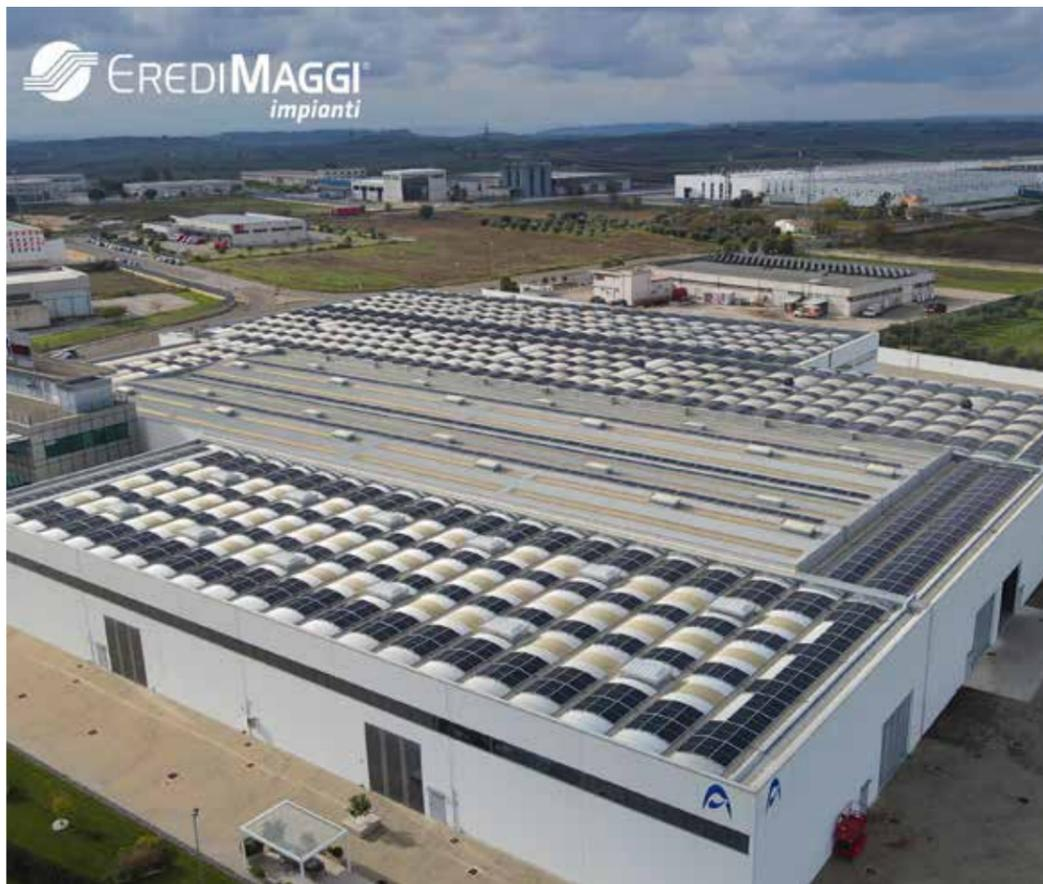
UN IMPIANTO DA 820 KWP REALIZZATO DA EREDI MAGGI A MATERA PER CONTO DELL'AZIENDA DOMAR. L'IMPIANTO È REALIZZATO CON MODULI LONGI SOLAR, INVERTER SMA E SISTEMI DI MONTAGGIO TILT E PRT DI CONTACT ITALIA
