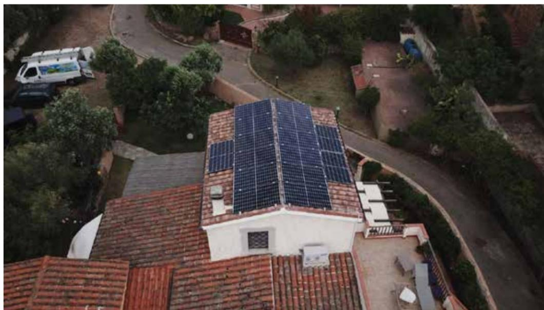
INTERVENTO REALIZZATO DA ENERGIE RINNOVABILI PETRETTO. SI TRATTA DELL'INSTALLAZIONE DI UN IMPIANTO FOTOVOLTAICO DA 6 KWP CON 15 MODULI FOTOVOLTAICI QCELLS DELLA POTENZA DI 400 W. L'IMPIANTO SFRUTTA UN INVERTER AZZURRO 1PH HYBRID 6000 ZSS E NON È DOTATO DI SISTEMA DI ACCUMULO. IL LAVORO È STATO FATTO SFRUTTANDO LA DETRAZIONE FISCALE AL 50%
