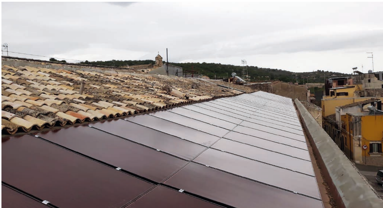
L'IMPIANTO FOTOVOLTAICO DA 20 KW POSIZIONATO SUL PALAZZO DI CITTÀ A FERLA
