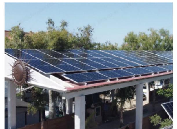
*la huella ecológica, a pesar de contar con un espacio de cubierta limitado. La instalación, compuesta por 63 módulos AIKO-A600-MAH72MW con una capacidad total de 37,8 kWp, fue suministrada por el distribuidor Plug and Play e instalada por Genkii.*
