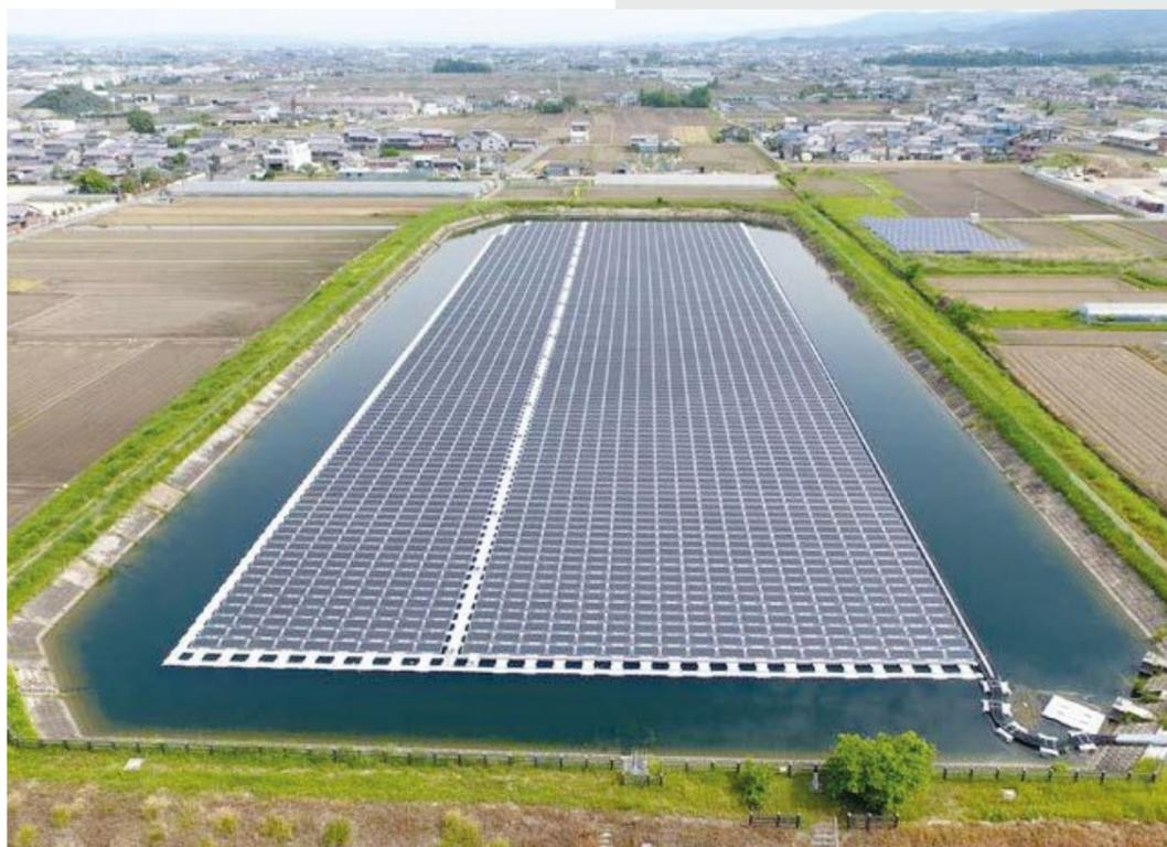
LAS INSTALACIONES FOTOVOLTAICAS FLOTANTES TIENEN UN RENDIMIENTO SUPERIOR EN COMPARACIÓN CON LAS TERRESTRES, YA QUE LA PROXIMIDAD AL AGUA OPTIMIZA LAS CONDICIONES PARA APROVECHAR AL MÁXIMO LAS CARACTERÍSTICAS DE LOS MÓDULOS DE ÚLTIMA GENERACIÓN.
