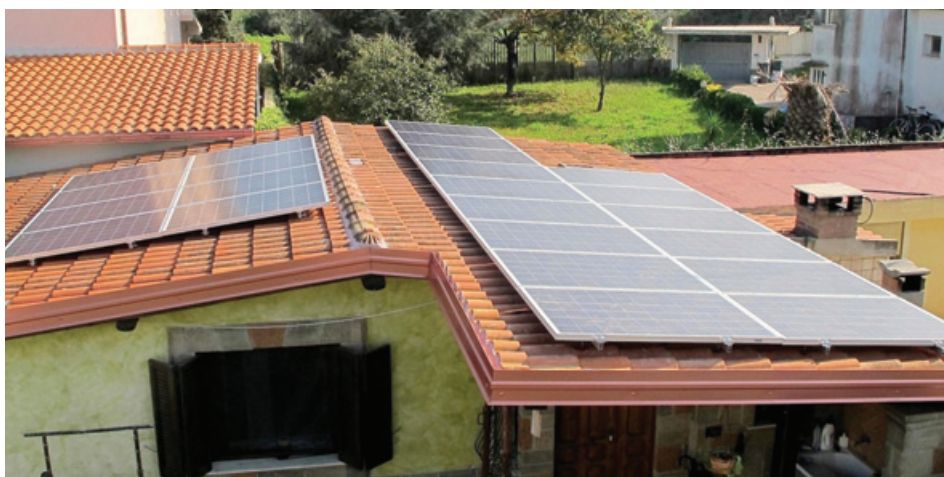
SUI TETTI DELLA VILLA E DELLA DEPANDANCE SONO STATI INSTALLATI 24 MODULI CONERGY, COLLEGATI AD UN INVERTER ABB
