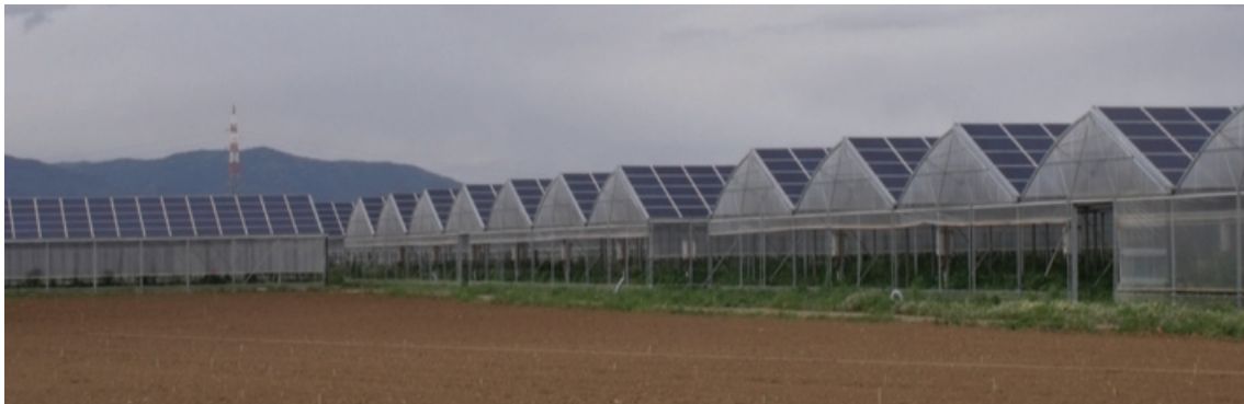
SUI TERRENI ACQUISTATI DAL COMUNE SONO STATI INSTALLATI CINQUE IMPIANTI COMPOSTI DA 57.375 MODULI SUNPOWER E 15 INVERTER SIEMENS
