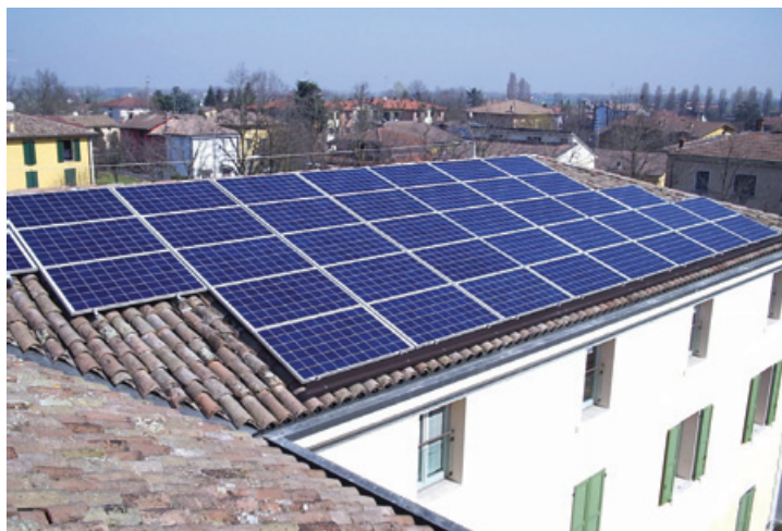
SUL TETTO DELLA SEDE MUNICIPALE DI GATTATICO SONO STATI INSTALLATI 19,6 KWP PER UNA PRODUZIONE ANNUA STIMATA DI 23MILA KWH
