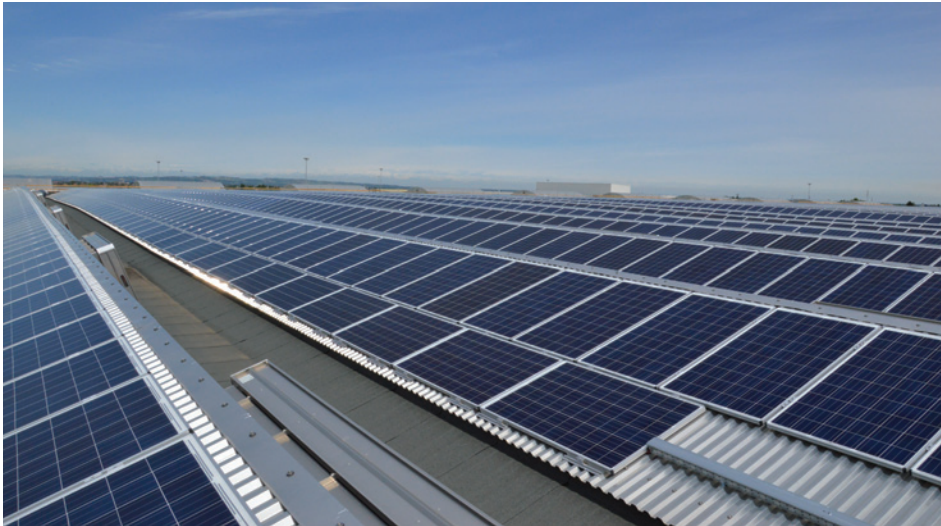
L'INSTALLAZIONE È COSTITUITA DA 3.910 MODULI SOLAR-FABRIK AG E TRE INVERTER CENTRALIZZATI ABB MONTATI SU SHED RETTILINEI
