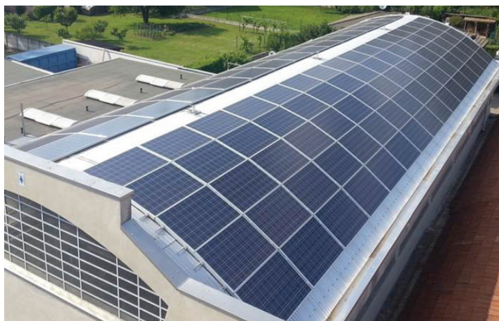
L'IMPIANTO REALIZZATO DA ELMEC SOLAR PER UN'AZIENDA MECCANICA DI BESNATE (VA) CON INVERTER SMA E MODULI ALEO SOLAR UTILIZZA IN AUTOCONSUMO IL 90% DELL'ENERGIA PRODOTTA. I TEMPI DI RIENTRO DELL'INVESTIMENTO SONO STIMATI IN CIRCA SETTE ANNI
