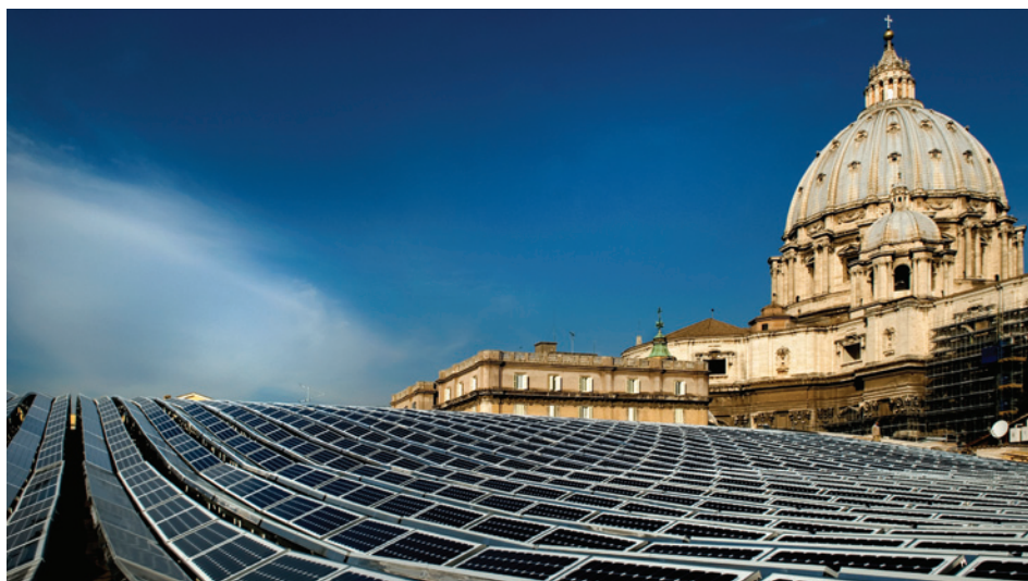
I MODULI INSTALLATI SULLA COPERTURA DELL'AULA PAOLO VI IN VATICANO PRODUCONO ENERGIA UTILIZZATA PER COPRIRE IL FABBISOGNO DELL'EDIFICIO DOVE IL PAPA TIENE LE UDIENZE SETTIMANALI
