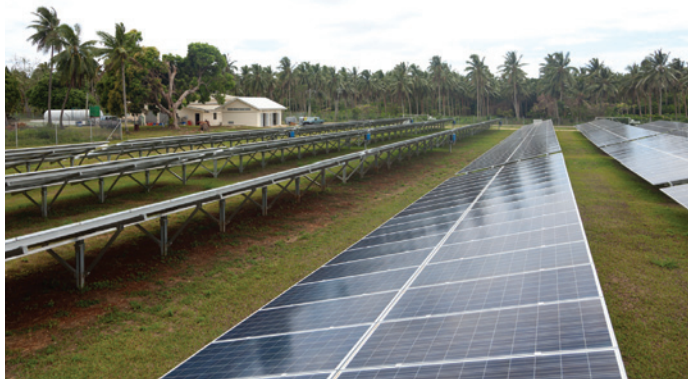
NELL'ISOLA DI VAVA'U, OCEANO PACIFICO, È STATO INSTALLATO UN IMPIANTO FOTOVOLTAICO DA 500 KW AD INTEGRAZIONE DEL GENERATORE DIESEL CHE CONSENTE UN RISPARMIO ANNUO DI CIRCA 255.000 LITRI DI GASOLIO
