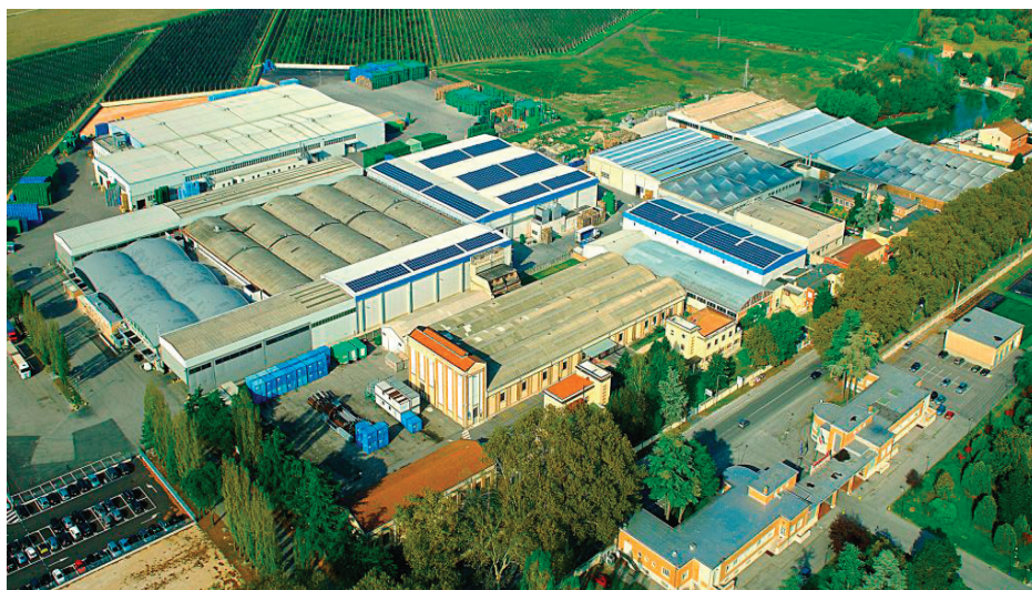
IL GRUPPO ORTOFRUTTICOLO MAZZONI SI È RIVOLTO AL FOTOVOLTAICO PER ABBASSARE LA BOLLETTA ENERGETICA. PER LE STRUTTURE DI TRESIGALLO E GAIBANELLA (FE), REALIZZATE DA ENERRAY, JINKOSOLAR HA FORNITO UN TOTALE DI 748 KWp DI MODULI FOTOVOLTAICI, DEI QUALI CIRCA 200 KW DOTATI DI OTTIMIZZATORI TIGO ENERGY
