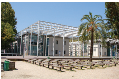
IL RISPARMIO DI ENERGIA PRIMARIA DEL CAMPUS È DI CIRCA 50 TONNELLATE DI PETROLIO L'ANNO CON UNA RIDUZIONE DELLA SPESA ENERGETICA DELL'ORDINE DI 60.000 EURO L'ANNO
