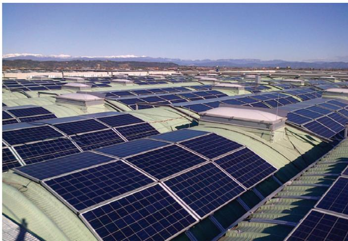
IL SISTEMA FOTOVOLTAICO È STATO STRUTTURATO PER PRODURRE IL MASSIMO DI ENERGIA POSSIBILE DATA LA SUPERFICIE A DISPOSIZIONE. A TAL FINE I MODULI SONO STATI POSIZIONATI SU UNA STRUTTURA DI SUPPORTO SAGOMATA IN MODO DA ADERIRE ALLA CURVATURA DELLA LAMIERA DI COPERTURA
