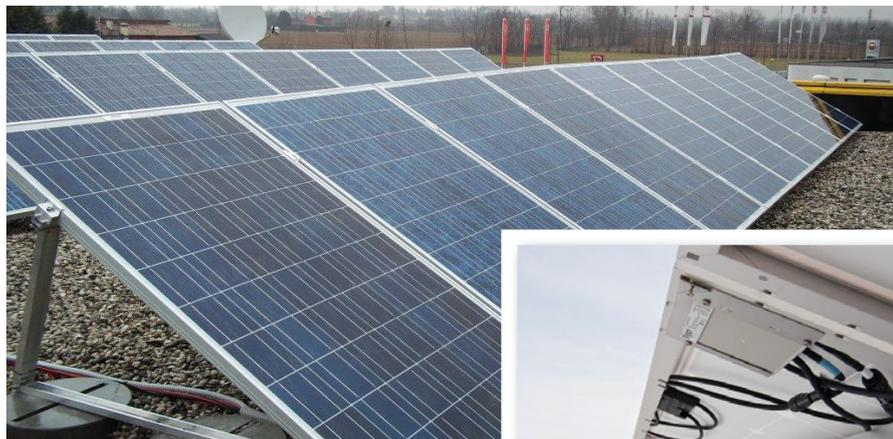
LA RESA DELL'IMPIANTO INSTALLATO PER IL CONDOMINIO SOLESETTE, IN SEGUITO ALL'APPLICAZIONE DEI MASSIMIZZATORI TIGO ENERGY, È PASSATA DA UN VALORE DI CIRCA 1.150 KWH/KWP DEL 2010 AGLI ATTUALI 1.350 KWH/KWP
