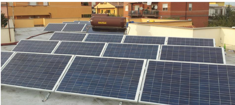
IMPIANTO FOTOVOLTAICO SUPER SOLAR ES250 DA 2,7 KWP E SISTEMA SOLARE TERMICO SUPER SOLAR SSN-200-RS2,60 INSTALLATI SUL TETTO DI UN'ABITAZIONE DI ROMA. LA SOLUZIONE COMBINATA CONSENTE UN AUTOCONSUMO DELL'ENERGIA ELETTRICA E TERMICA DEL 75% E UN RISPARMIO ENERGETICO PARI AL 55%
