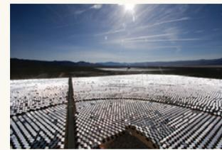
È entrato in esercizio nel deserto del Mojave, in California, Ivanpah Solar Electric Generating System, il più grande impianto solare a concentrazione del mondo. L'installazione, che occupa un'area di circa otto chilometri quadrati, è formata da 170.000 specchi. Raggiunta la piena capacità, si stima che l'impianto potrà produrre 392 MW di energia elettrica.
