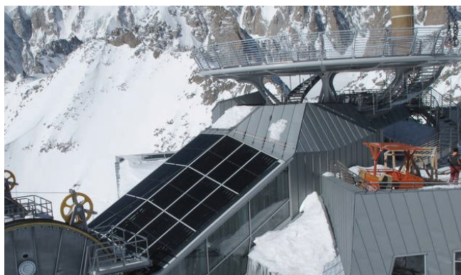
IMPIANTO FOTOVOLTAICO DA 12,7 KW REALIZZATO PER LA STAZIONE FUNIVIARIA DI PUNTA HELBRONNER, A COURMAYEUR (AO) A 3.500 METRI SUL LIVELLO DEL MARE
