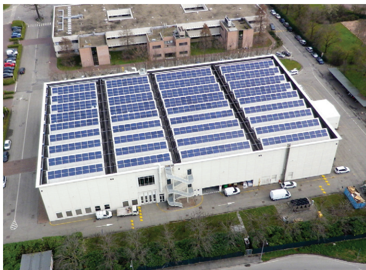
IMPIANTO DA 174,7 KWP REALIZZATO DA ENERRAY SULLA COPERTURA DI UN'AZIENDA MECCANICA. GRAZIE ALLA PRODUZIONE DA FONTE FOTOVOLTAICA, IL COMMITTENTE AVRÀ UN RISPARMIO DI CIRCA 40MILA EURO L'ANNO SULL'ACQUISTO DELL'ENERGIA
