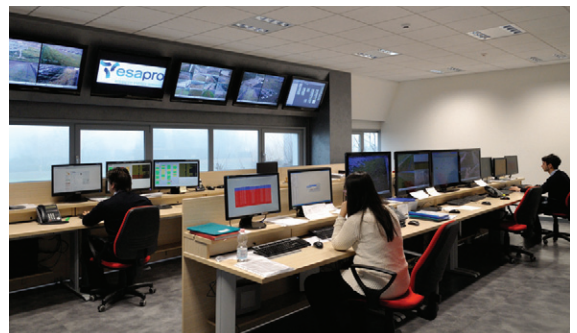
IL MONITORAGGIO DEI GRANDI IMPIANTI VIENE EFFETTUATO DA REMOTO ATTRAVERSO APPOSITI SOFTWARE CHE EFFETTUANO LA LETTURA E L'ANALISI DEI DATI 24 ORE SU 24
