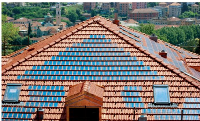
LE TEGOLE SOLARI CONSENTONO DI INTEGRARE IL FOTOVOLTAICO NEL PIENO RISPETTO DELL'ESTETICA DI COPERTURE TRADIZIONALI
