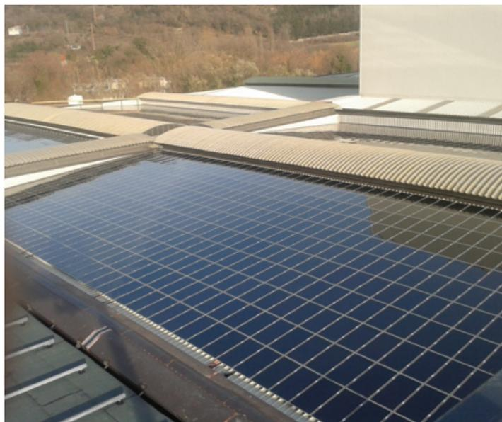
L'IMPIANTO È COSTITUITO DA 17.530 MODULI DISPOSTI IN PARTE SU SUPERFICIE PIANA E IN PARTE SU FALDE INCLINATE
