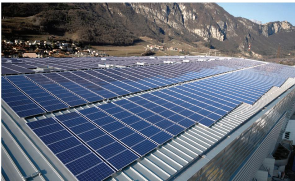
L'IMPIANTO COMPOSTO DA 3.200 MODULI SUNMODULE PLUS, INSTALLATO SUI TETTI DELLA COOPERATIVA VINICOLA CAVIT DI RAVINA DI TRENTO (TN) PRODUCE CIRCA 830 MWH ALL'ANNO DI ENERGIA PULITA, A VANTAGGIO DELLA BOLLETTA ENERGETICA, OLTRE AD ACCRESCERE IL VALORE DEGLI EDIFICI
