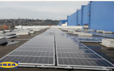
È entrato in esercizio l'impianto fotovoltaico da 4 MW installato dal gruppo Derbigum sui tetti del deposito Ikea di Lione composto da circa 15.000 moduli fotovoltaici posati sul tetto in seguito ad un intervento di impermeabilizzazione. Per l'installazione Ikea ha investito complessivamente 11,6 milioni di euro.
