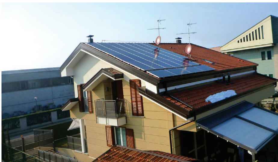
IL SISTEMA FOTOVOLTAICO REALIZZATO SUL TETTO DI UNA VILLETTA DI VEDANO AL LAMBRO (MB), INSTALLATO ALL'INIZIO DEL 2013, GRAZIE ALL'IMPIEGO DI MODULI DOTATI DI OTTIMIZZATORI, NEI DUE ANNI DI ESERCIZIO HA PRODOTTO QUASI IL 6% IN PIÙ RISPETTO ALLE STIME, CONSENTENDO UN RISPARMIO SULLA BOLLETTA DEL 60% CIRCA
