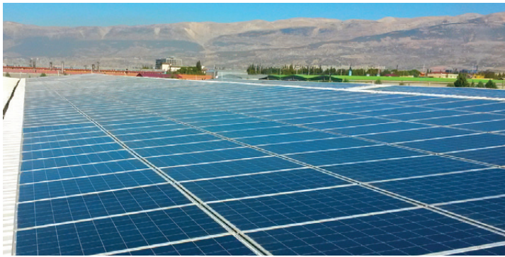
L'IMPIANTO, COMPOSTO DA 2.941 MODULI, PER UNA POTENZA DI 750 KWP, E 41 INVERTER, È DISTRIBUITO SU UNA SUPERFICIE DI 30MILA METRI QUADRI
