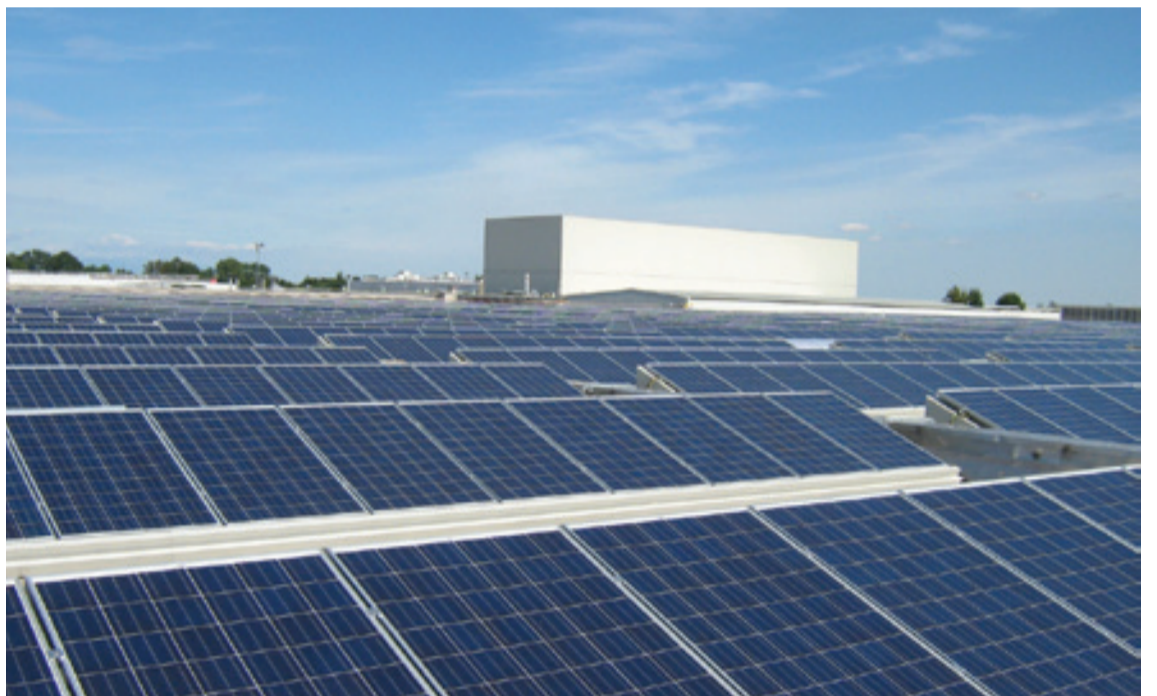
ÈNOSTRA COOP ACQUISTA ENERGIA DA IMPIANTI SELEZIONATI PER POI RIVENDERLA AI SUOI SOCI. L'ULTIMO PRODUTTORE A ESSERSI AGGIUNTO È ANERG ITALIA, CHE SI OCCUPA DI PROGETTARE, PRODURRE E INSTALLARE BANCHI FRIGO PER I SUPERMERCATI. IN QUESTA FOTO, L'IMPIANTO INSTALLATO SUL TETTO DELLA SEDE DI ANERG ITALIA
