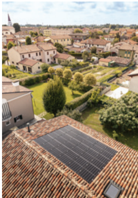
18 MODULI REC ALPHA SONO COLLEGATI A UN INVERTER SOLAREEDGE HD WAVE, CHE DIALOGA ALLO STESSO TEMPO CON UN SISTEMA DI ACCUMULO CON BATTERIE LG CHEM DA 7 KWH
