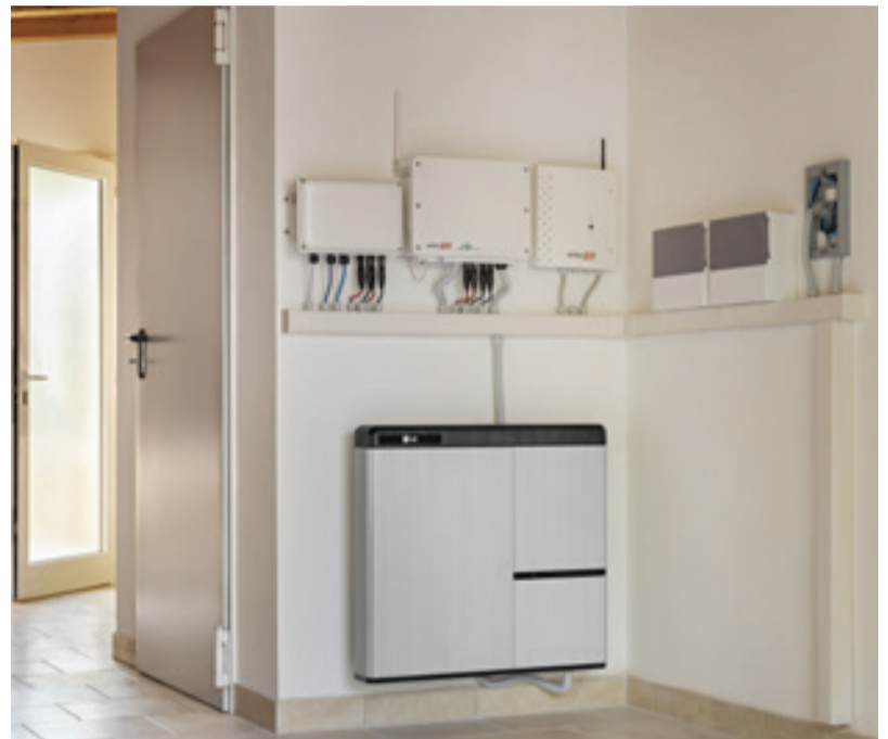
18 MODULI REC ALPHA SONO COLLEGATI A UN INVERTER SOLAREEDGE HD WAVE, CHE DIALOGA ALLO STESSO TEMPO CON UN SISTEMA DI ACCUMULO CON BATTERIE LG CHEM DA 7 KWH
